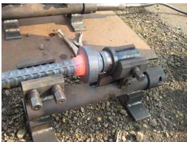
施工後 (DBヘッド完成)
