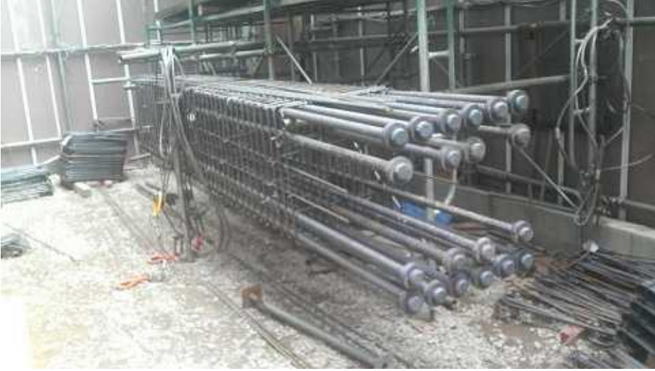
組立状況(現場先組)
