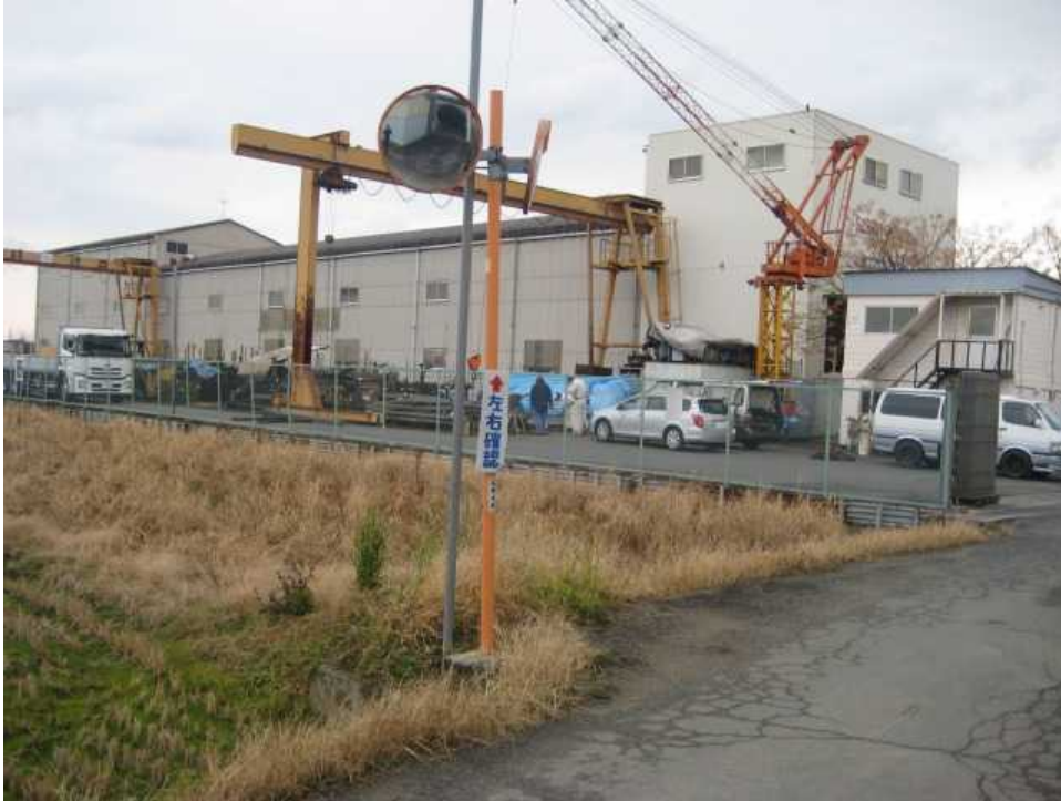
(株)長木鉄筋 奈良加工センター
