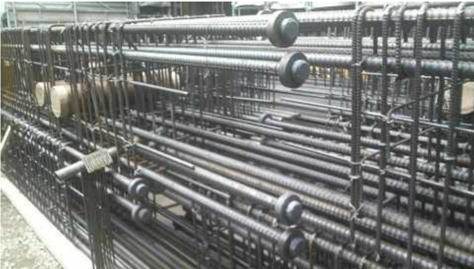
組立状況(現場内にて仮置き)
